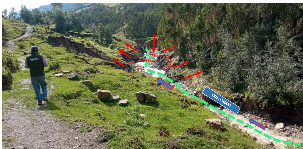
FIGURA N°01: MATERIAL SEDIMENTADO LO CUAL REDUCE LA SECCION HIDRAULICA DEBIDO A LA COLMATACIÓN DEL CAUCE
