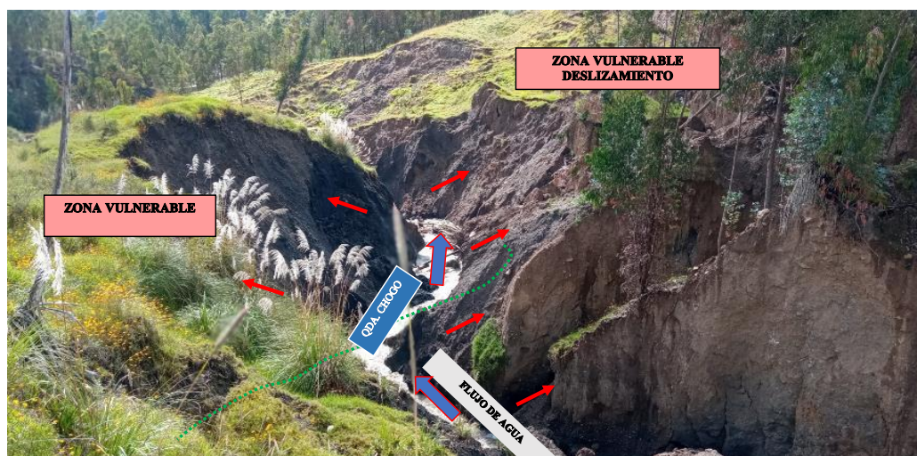
FIGURA N° 05: VISTA DE LA QUEBRADA CHOGO, SECCION MAS ANGOSTO DONDE POR EL DESPLAZAMIENTO DE TIERRAS DE LA MARGEN IZQUIERDA HA REDUCIDO LA SECCION.
