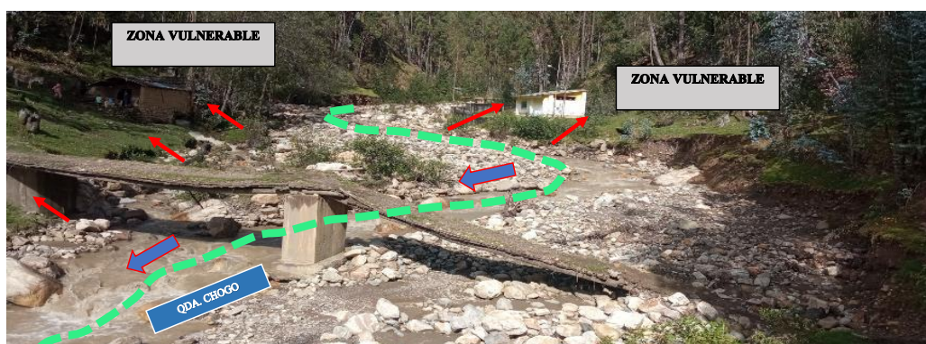
FIGURA N°03: CAUCE COLMATADO PUENTE PEATONAL COLAPSADO
