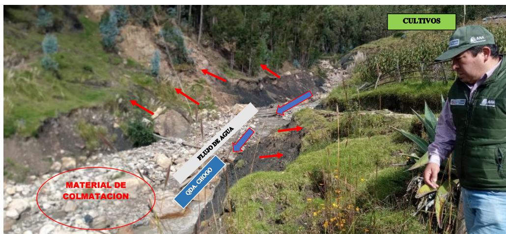
FIGURA N° 04: VISTA DE LA QUEBRADA CHOGO, SECCION COLMATADO DONDE POR EL DESPLAZAMIENTO DE TIERRAS DE LA MARGEN IZQUIERDA HA REDUCIDO LA SECCION, HAY ROCAS GRANDES, CULTIVOS EXPUESTOS.
